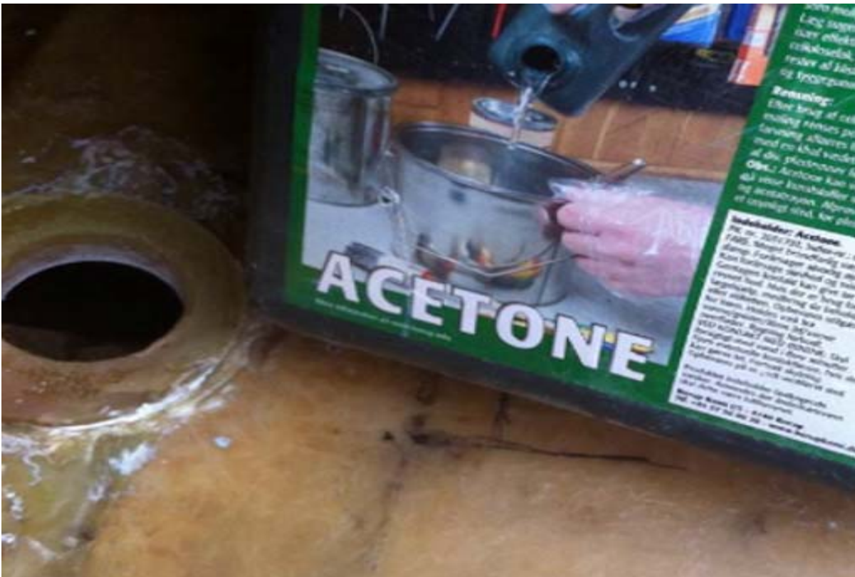
Hullet rengøres på inderside hvor transducer spændes på
